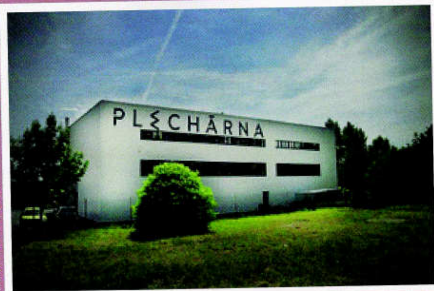
po rekonstrukci - rok 2015
